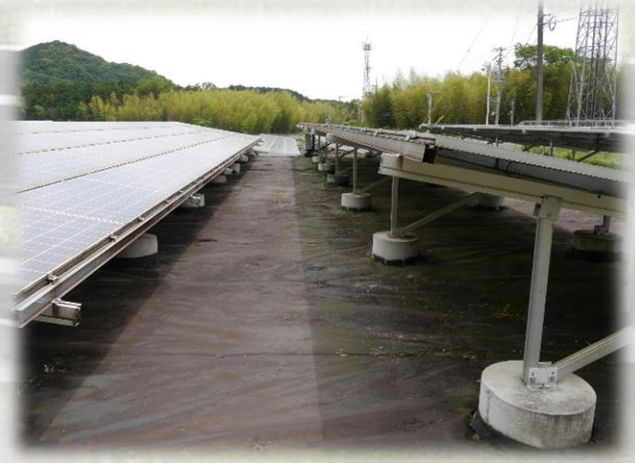
8年経過施工事例
