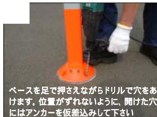
ベースを足で押さえながらドリルで穴をあけます。位置がずれないように、開けた穴にはアンカーを仮差込みして下さい
