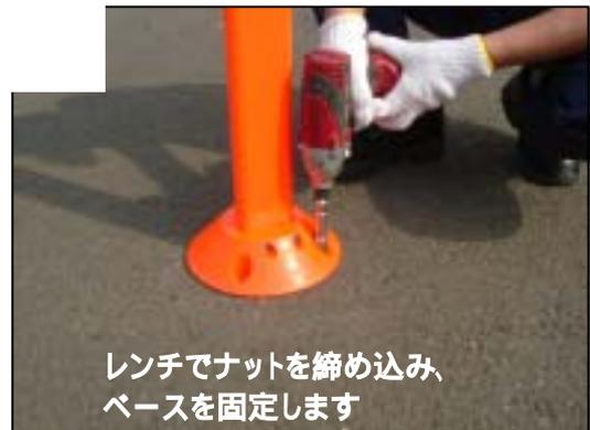
レンチでナットを締め込み、ベースを固定します
