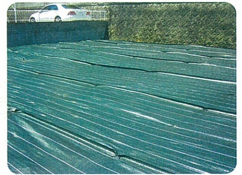
⑥広い面積の場合は複数のグランドバリアクロスを杭打ち手順に沿って繰り返して完了します。
