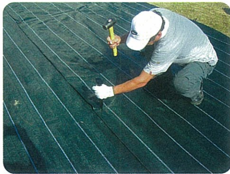
④グランドバリアクロスを広げて長さ方向の白い線を目安に端から10cm程度重ね合わせて約1m間隔に杭を打ち固定します。
