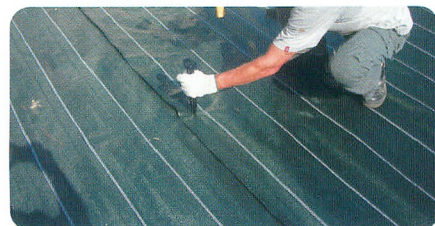
④ グランドバリアクロスを広げて長さ方向の白い線を目安に端から10cm程度重ね合わせて等間隔に杭を打ち固定します(間隔は右下の目安を参照してください)。
