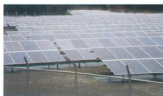
太陽光発電施設の防草対策
