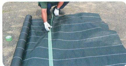
⑤ 原反をカットする場合は養生テープを表面に真直ぐに張り、カットすれば切り口が綺麗に仕上がります。
