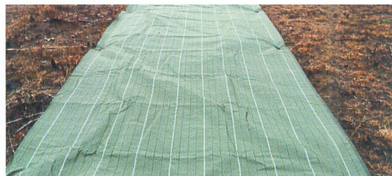
法面、路肩の長期間の防草対策
