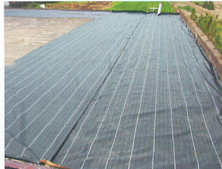
駐車場の防草・防塵対策
